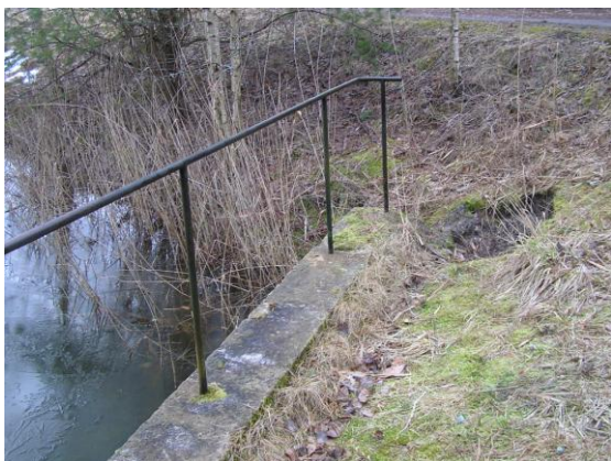
Fotod 3 ja 4. Kullamaa tehisjärve regulaatori voolusuunas vasakpoolne tugisein.
