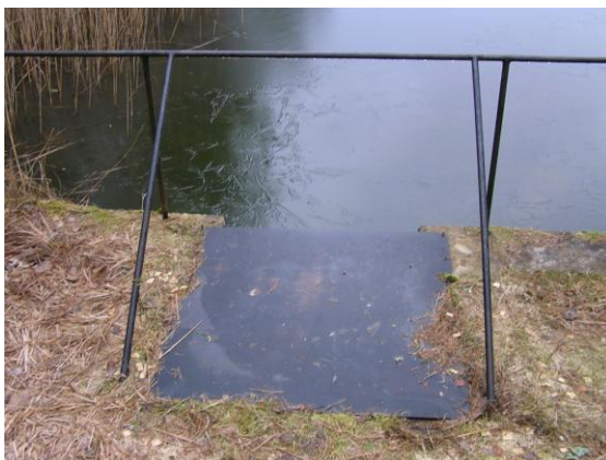
Fotod 7 ja 8. Kullamaa tehisjärve regulaatori ülevool ja varjad.
