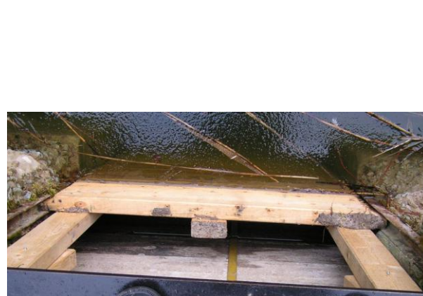
Fotod 7 ja 8. Kullamaa tehisjärve regulaatori ülevool ja varjad.
