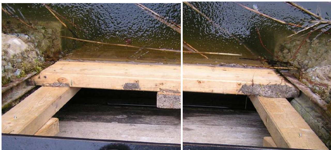
Fotod 13 ja 14. Regulaatori varjad ja nende kinnitused.
