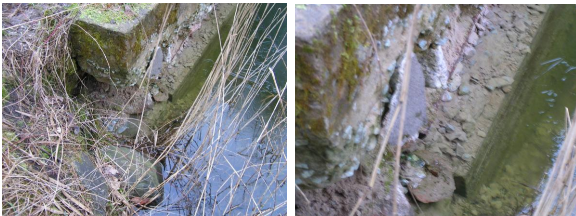
Fotod 9 ja 10. Kullamaa tehisjärve regulaatori voolusuunas vasakpoolne varisemisohtlik tugisein.
