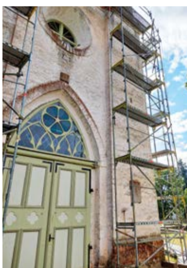
Kullamaa kirikutorni vahekarniisi restaureerimistööd. Foto Margus Jehu
